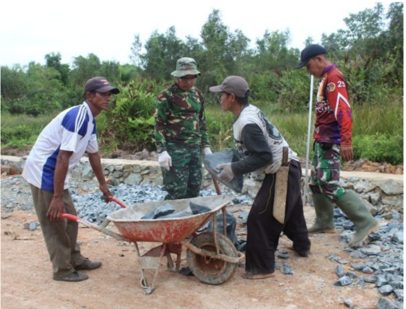
Personel Satgas TMMDKe - 117, Kerjakan Siring Jalan
